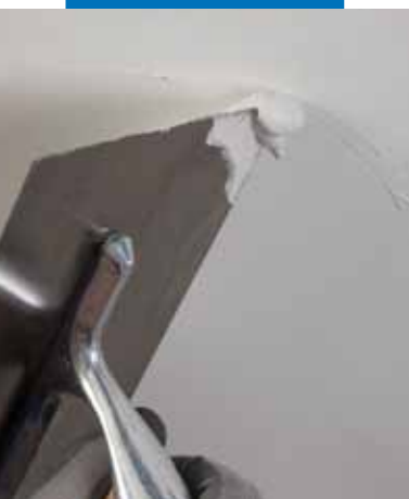
Vyhlazování výrobku ocelovým hladítkem
