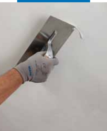
Způsob nanášení Mape-Antique FC Ultrafine
