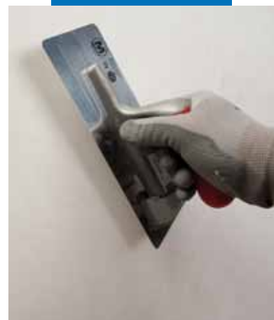
Aplikace druhé vrstvy Mape-Antique FC Ultrafine
