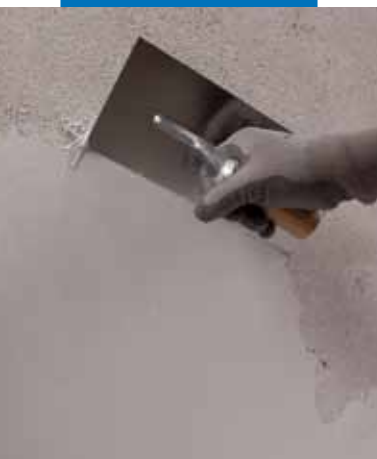
Aplikace první vrstvy Mape-Antique FC Ultrafine
